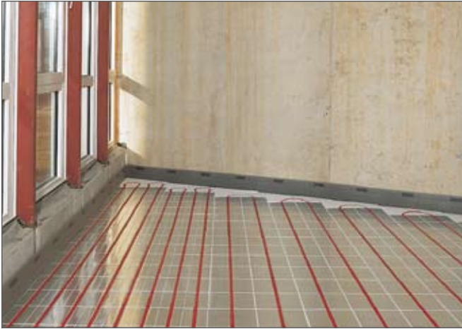
Fig. 3-54 Sistemul REHAU uscat
