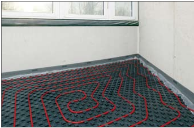
Fig. 3-11 Sistemul REHAU Placa cu nuturi varionova cu subizolație fonică de tip 30-2
