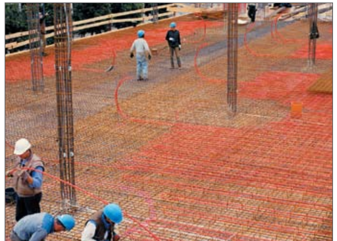
Fig. 8-5 Modul REHAU BKT montat la fața locului (pe șantier)
