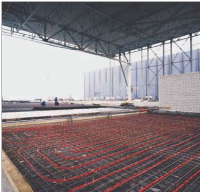
Fig. 9-1 Încălzirea prin pardoseală la un spațiu industrial
