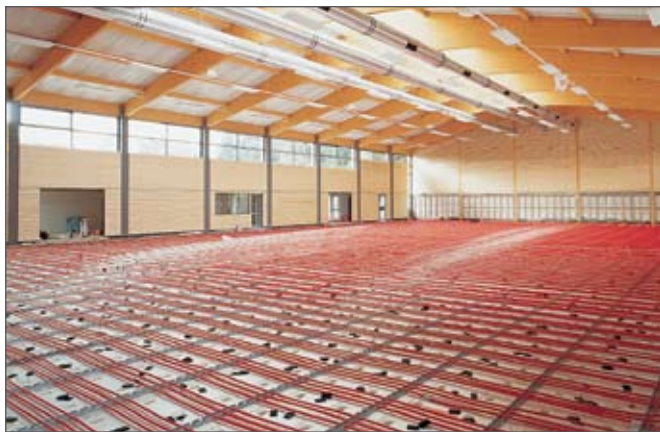
Fig. 9-22 Încălzirea prin pardoseală elastică- Sistemul cu distribuitor pentru țevi
