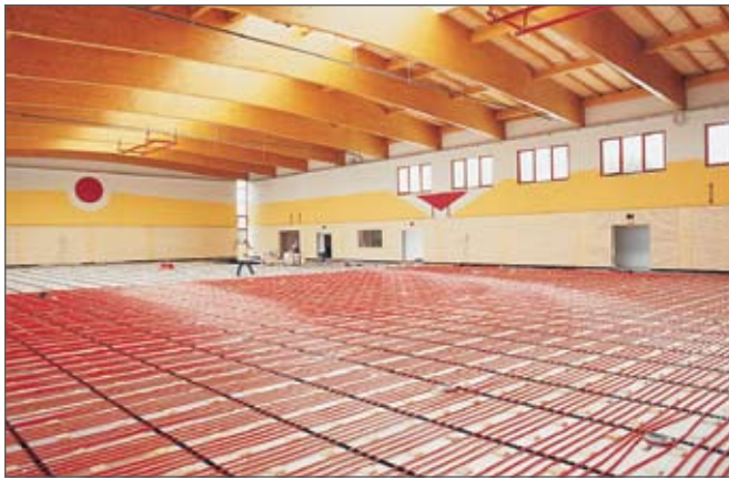
Fig. 9-16 Încălzirea prin pardoseală elastică- Sistemul cu distribuitor standard
