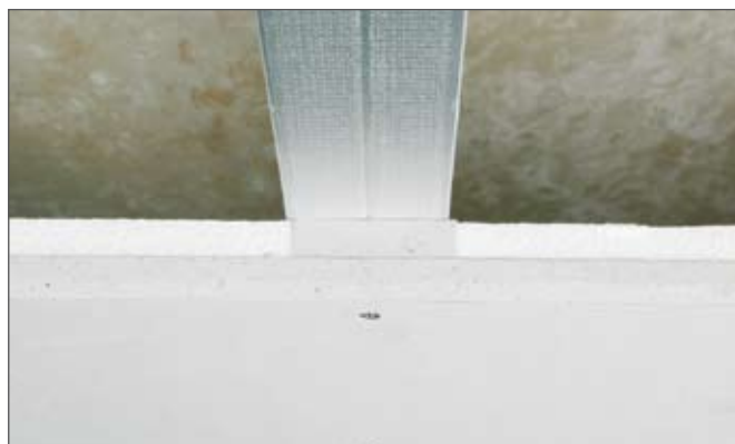
Fig. 4-6 Elemente de prindere în tavan montate
