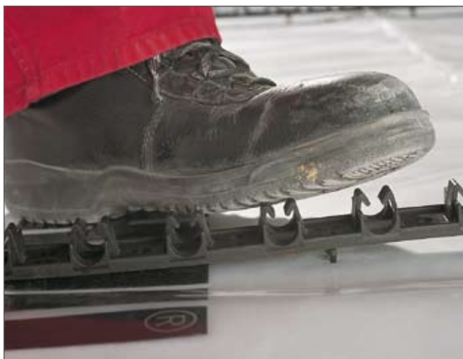
Fig. 3-39 Șinele REHAU-RAUFIX se vor apăsa în podea.
