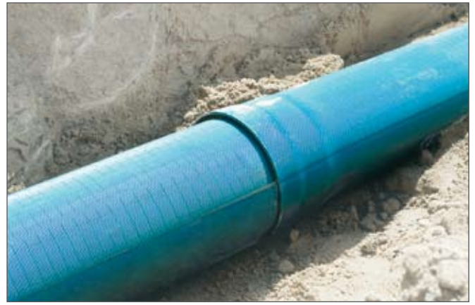
Fig. 9-32 Țevile de drenaj se montează pe terenul de joc
