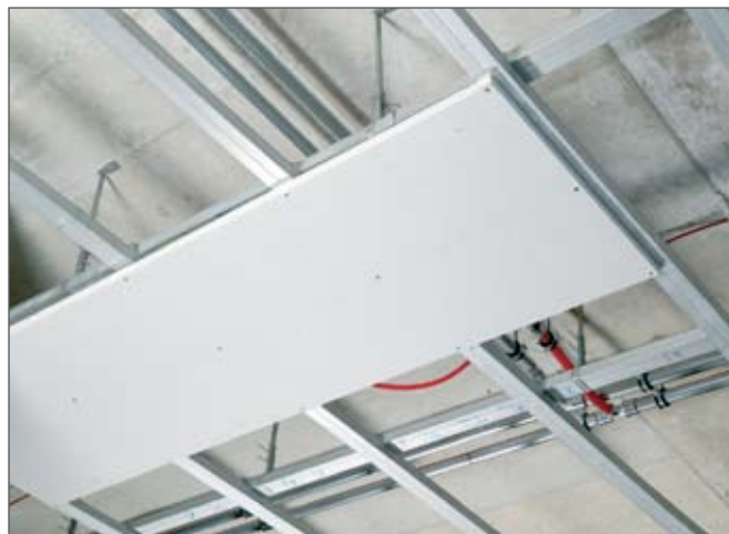
Fig. 4-34 Montarea elementelor de perete pe planșeu
