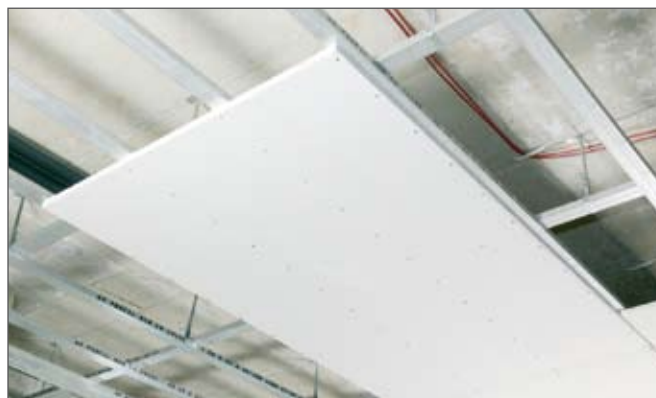
Fig. 4-5 Element de planșeu montat
